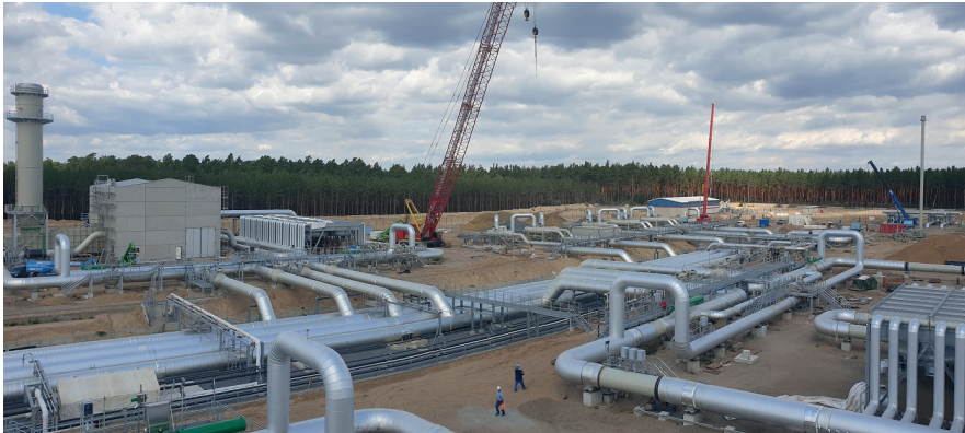
Bild 1: Baustelle des Projekts VS Radeland 2 im Jahr 2020
