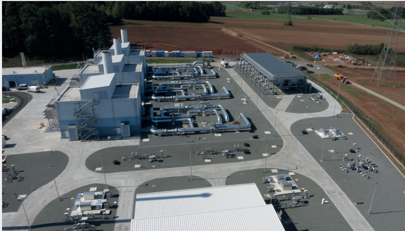
Bild 3: Die Verdichterstation MEGAL Rothenstadt ging 2018 in Betrieb.
