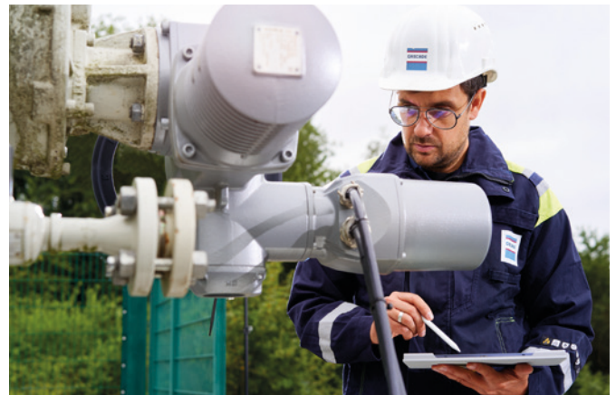
Bild 4: Überprüfung einer Armatur vor Ort und systematische Erfassung kleinster Komponenten
